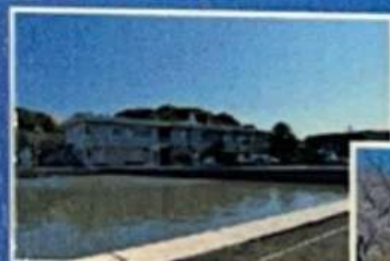
【緩速ろ過池と管理棟】
